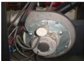
Ventilator și senzor de temperatură pentru gaze de ardere
